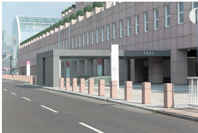
Treppe und Eingangsbereich von Halle 9 © Ingo Schrader
