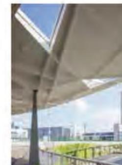
den musste. Die einheitliche Bauweise macht komplizierte Profile und Anschlüsse überflüssig. Die auf das Wesentliche reduzierte Ästhetik wird von den einfachen Details der Konstruktion zusätzlich unterstützt. Die aus Sperrholzplatten bestehende Dacheindeckung ist oberseitig mit Polyurethan beschichtet. In die Platten eingefräste Nuten nehmen die Verkabelung für Beleuchtung, Heizkabel, Kameras etc. auf.
