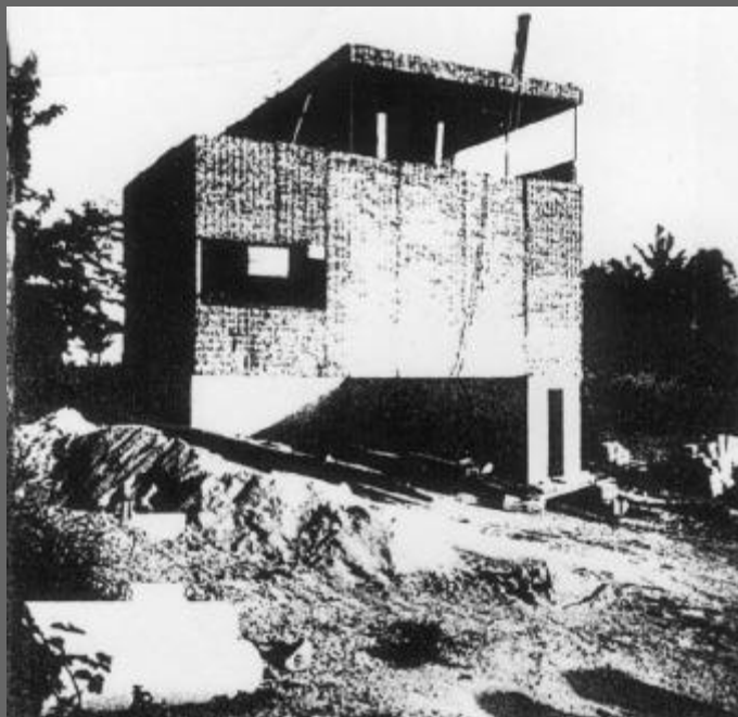
Maison Ruf im Bauzustand (A.Rüegg: Villa Ruf, ETHZ 1987)
